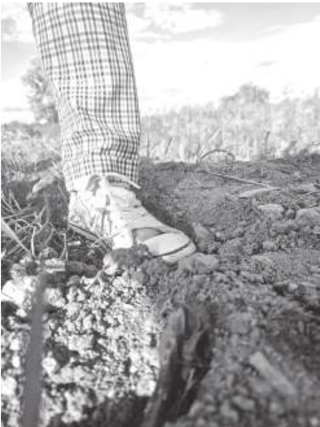
В свежееотсыпанной обочине утопают ноги...
