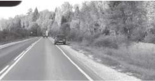
Ширина отвода дороги не позволяет разместиться на нём автомобилю, не заезжая на проезжую часть
