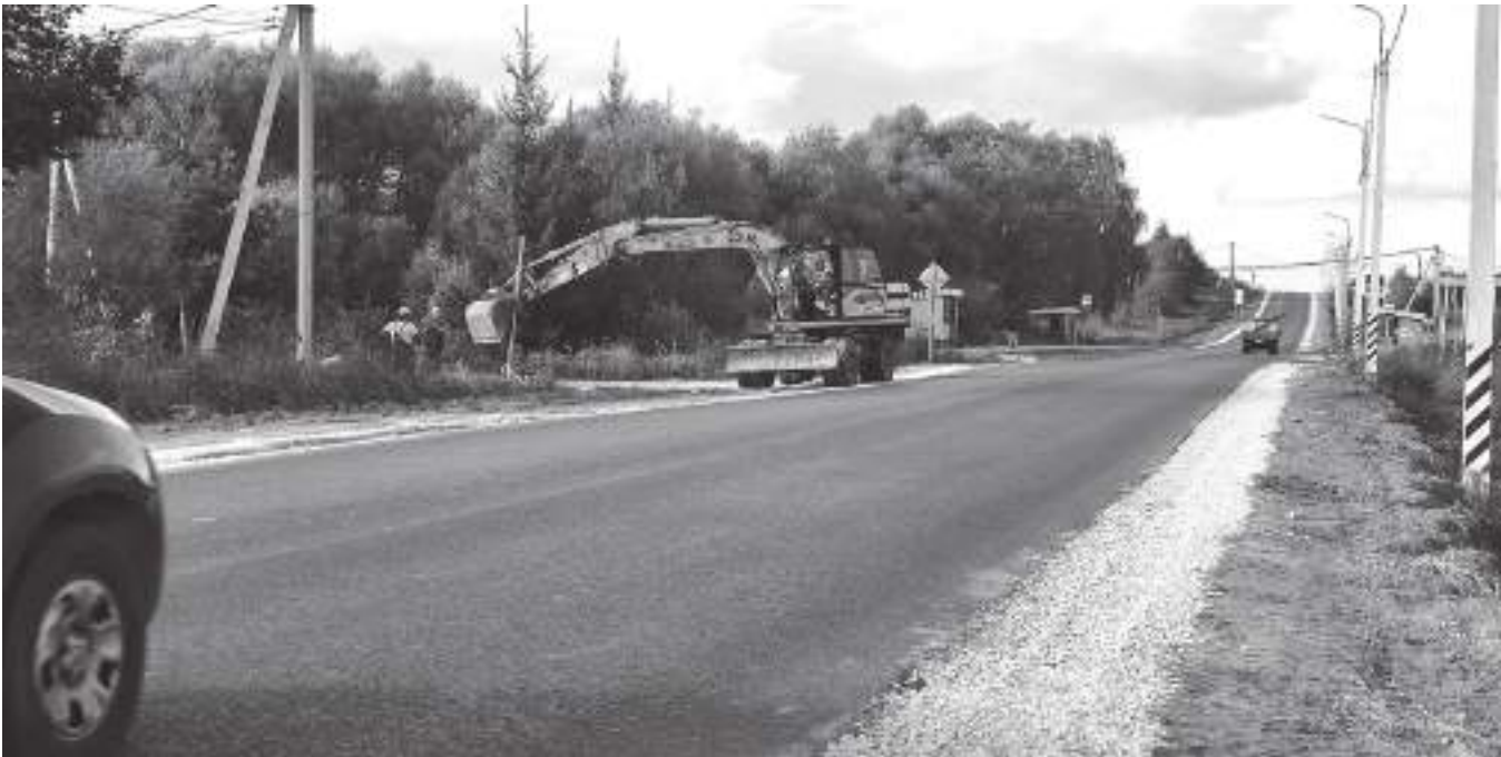
Новые опоры дорожных знаков забивают прямо ковшом экскаватора
