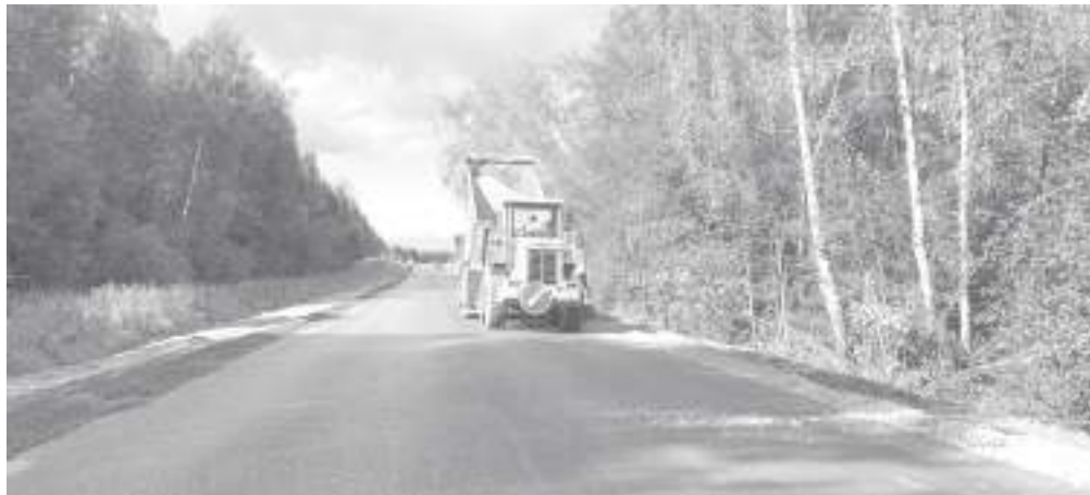
Перекрывая проезжую часть спецтехникой, подрядчик не всегда задумывается о безопасности дорожного движения: ни регулировщика, ни ограждений
