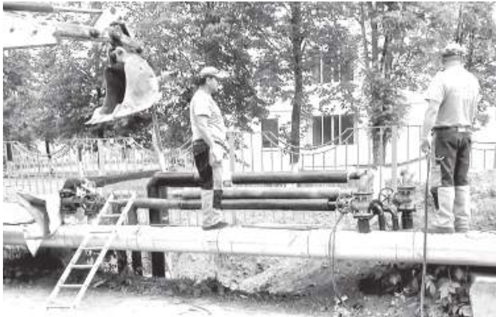
В этом году по областной программе заменили теплотрассы сразу на трёх участках в городе
