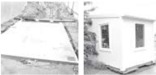
Скоро к собору подведут отопление. Строители готовятся произвести монтаж новой котельной
