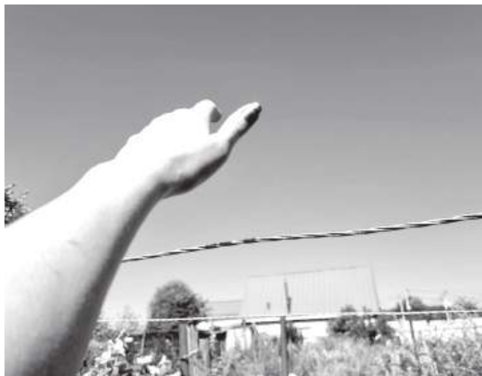
Провода провисли так, что достать до них может даже очень невысокий человек
