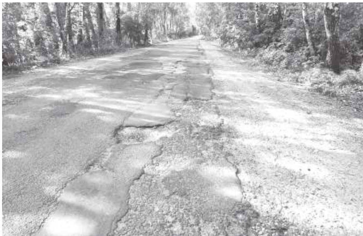
Кромка асфальта по краям проезжей части разрушилась настолько, сузив дорогу, что разъехаться на ней двум авто стало проблематично
