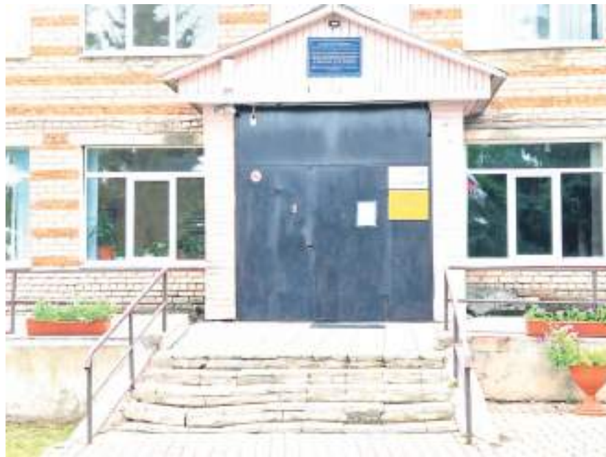
Отремонтировать крыльцо руководство школы хочет, войдя в федеральную программу
