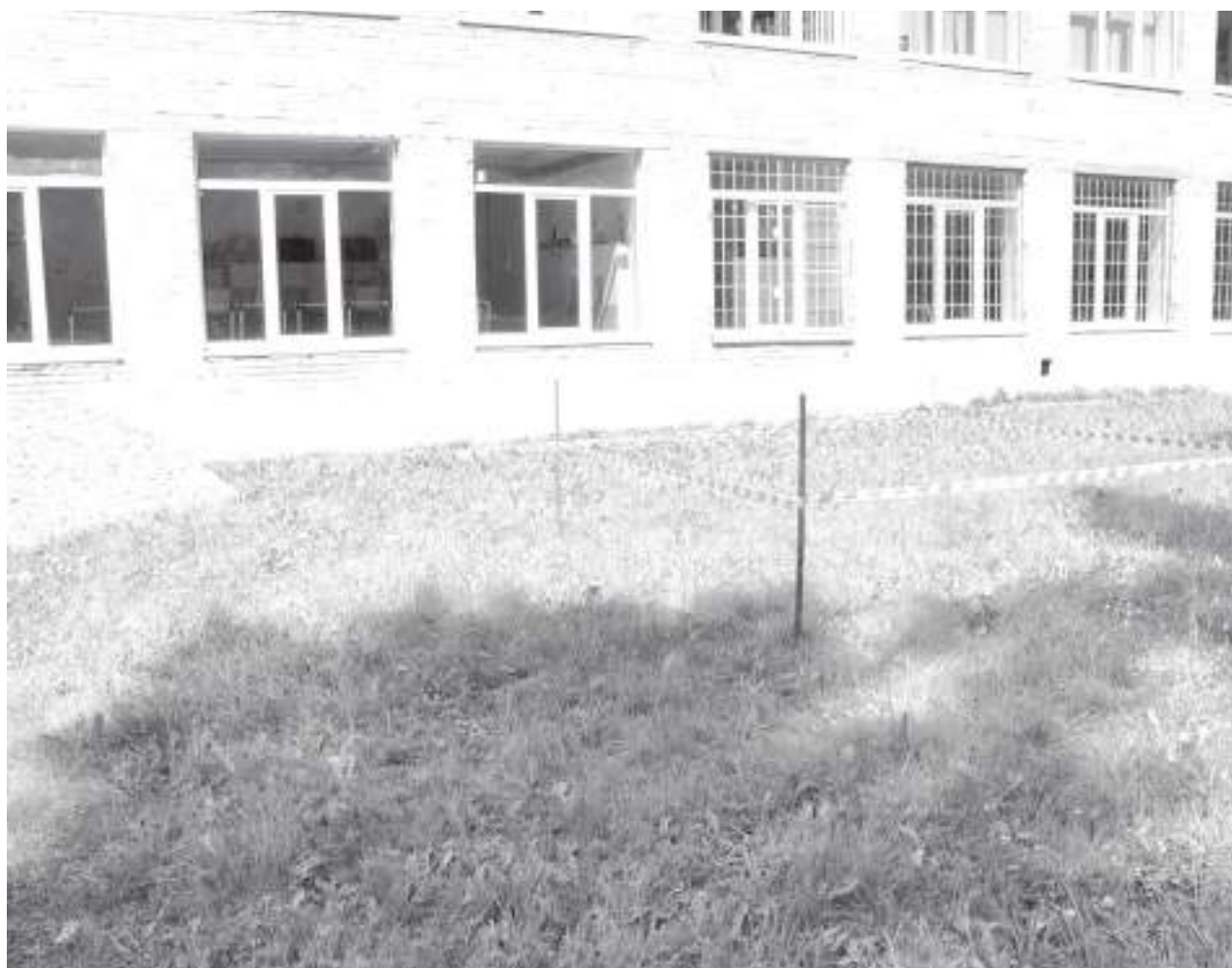
Строители приступают к оборудованию будущей метеостанции
