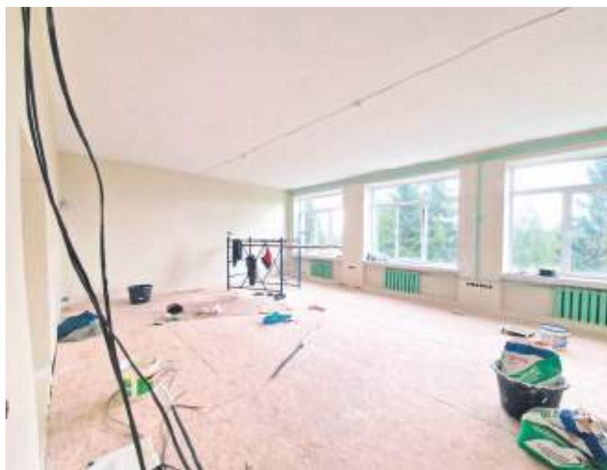
В двух кабинетах уже проведена часть работ
