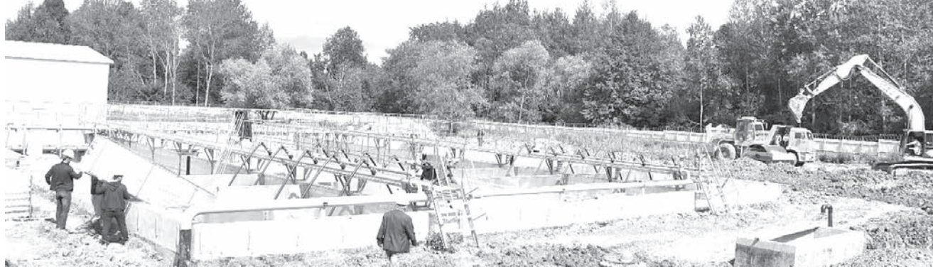
В блоке доочистки воды полным ходом производится монтаж оборудования
