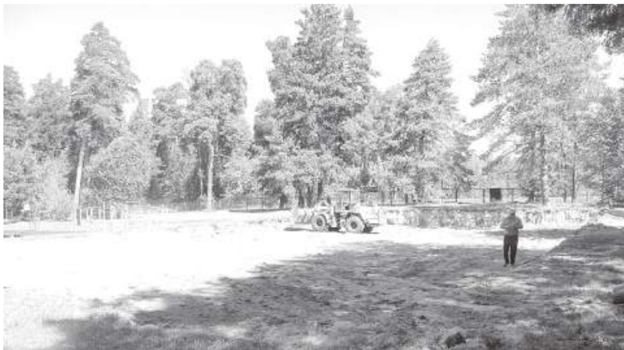
Идёт строительство хоккейной площадки
