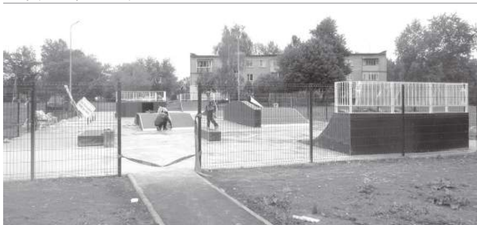
Идёт строительство скейт-парка
