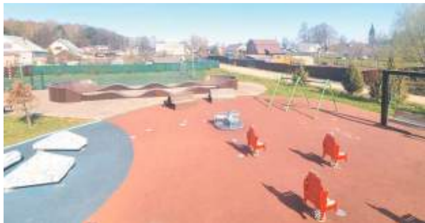
Большая многофункциональная площадка «Нарния» в Боровске тоже потихоньку разваливается. Покрытие в спортивной зоне вздулось и отвалилось. Деревянные конструкции рассохлись, обшивка скейт-площадки отошла. К слову, чистотой «Нарния» тоже не блещет. Урны переполнены, по всей территории валяется мусор. Коммунальщики заглядывают туда только по запросу администрации
