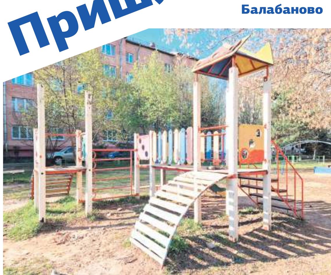
Площадке на Лесной требуются и ремонт, и покраска, и бережное отношение
