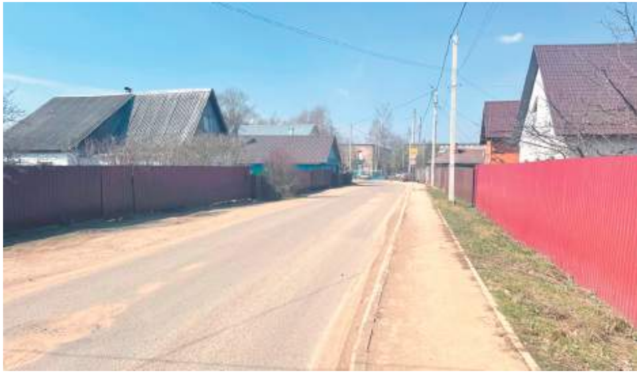
При очистке обочин страдают тротуары. Возникает вопрос, людям теперь ходить по дороге или задыхаться от пыли?
