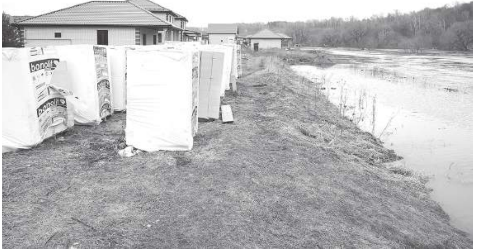
Вода подступает вплотную к коттеджам вторую весну подряд
