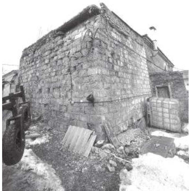
Бассейн несколько лет назад пришлось закрыть – разваливаются стены пристройки, в котором он расположен
