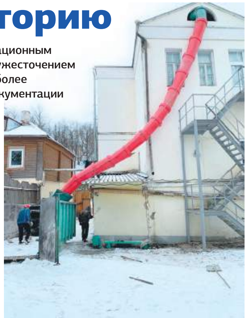
Строителям пришлось вывезти 30 тонн мусора и птичьего помёта, прежде чем проложить тепло и гидроизоляцию кровли
