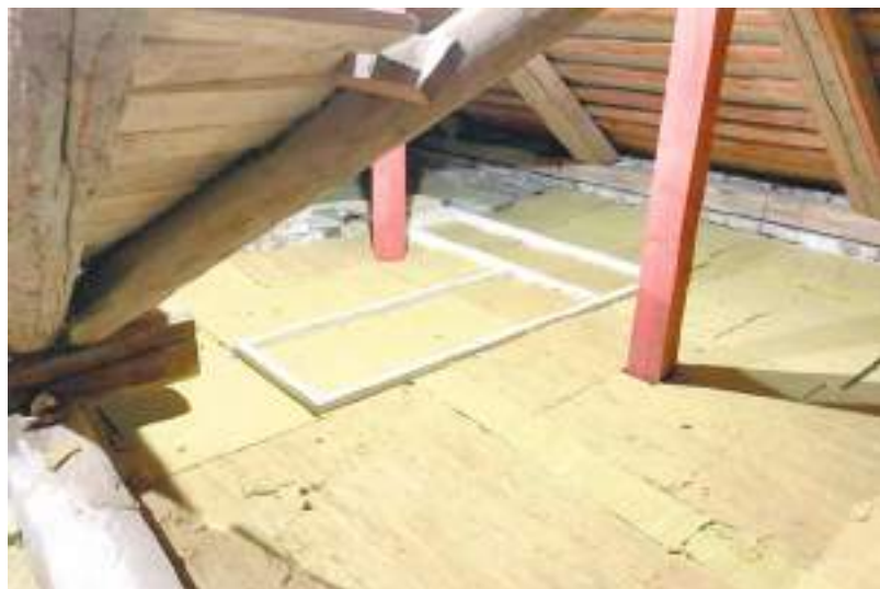
Проведённые работы позволили сократить количество теплопотерь и свели на нет образование конденсата в чердачных помещениях
