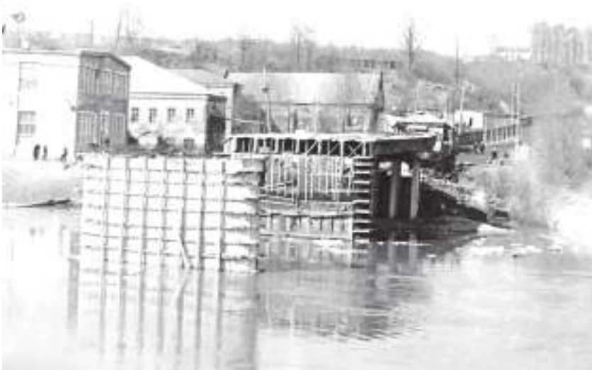
Так строился автомобильный мост через Протву, по которому сегодня мы привычно въезжаем в город
