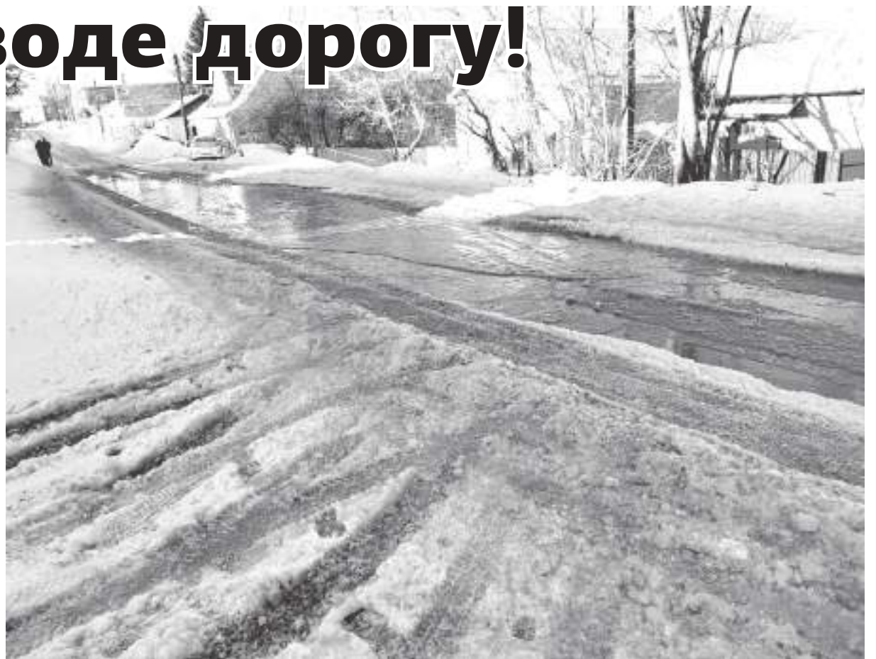
Огромная лужа на Московской в Боровске образуется из-за отсутствия водоотвода
