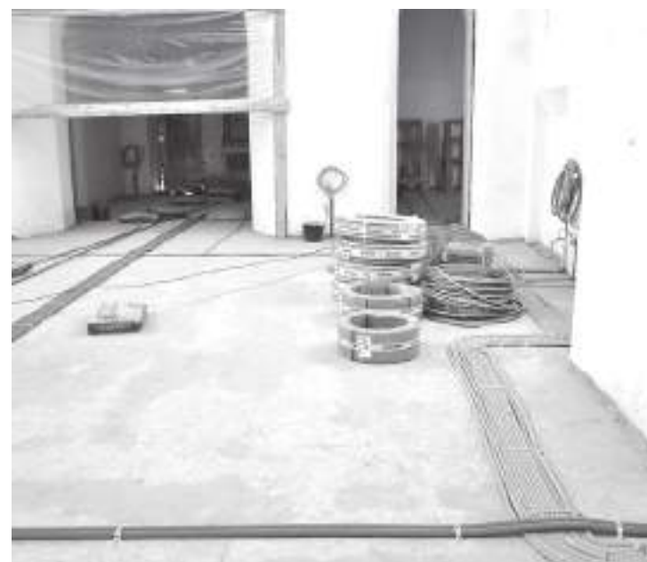
В храме готовятся к укладке труб тёплого пола, проводится разводка электричества
