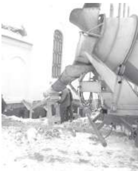
На прошедшей неделе строители смогли залить бетоном специально смонтированный металлический каркас будущего фундамента
