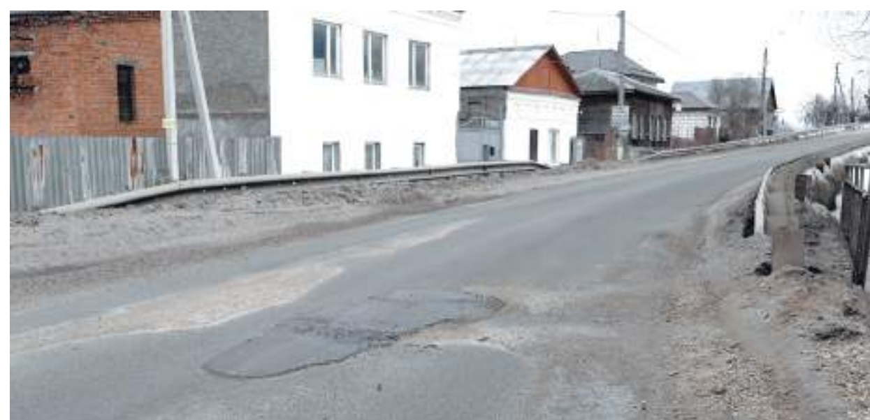
Глубокую яму на Урицкого залатали литым асфальтом. Его можно использовать при температуре до минус 10°C
