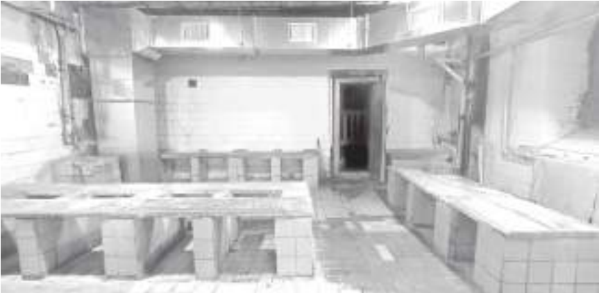
В конце прошлого года в общественной помывочной «реанимировали» вентиляцию
