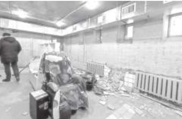
В комнате отдыха отремонтируют потолок, заменят радиаторы отопления и плитку на стенах
