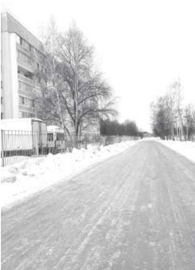
Смета на ремонт улицы Молодёжной готова, однако пока не найдено финансирование
