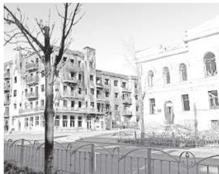
Разрушенных зданий в городе больше, чем целых
