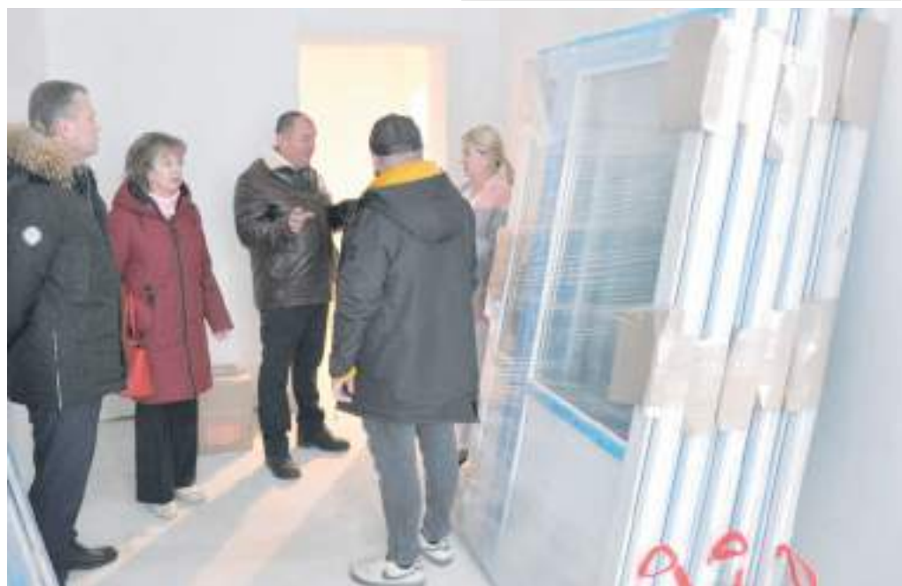
В ЦРБ завезли порядка 120 межкомнатных дверей. Они примечательны тем, что разработаны с усиленными петлями. Строители начали их установку
