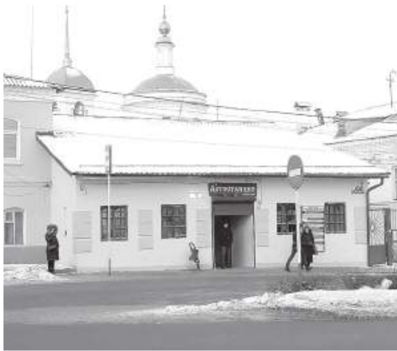
До конца года в здании боровской автостанции появится отопление. Реконструкция объекта запланирована, но сроки сдвинулись
