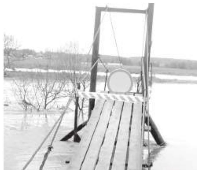
Мост будут не ремонтировать, а демонтировать
