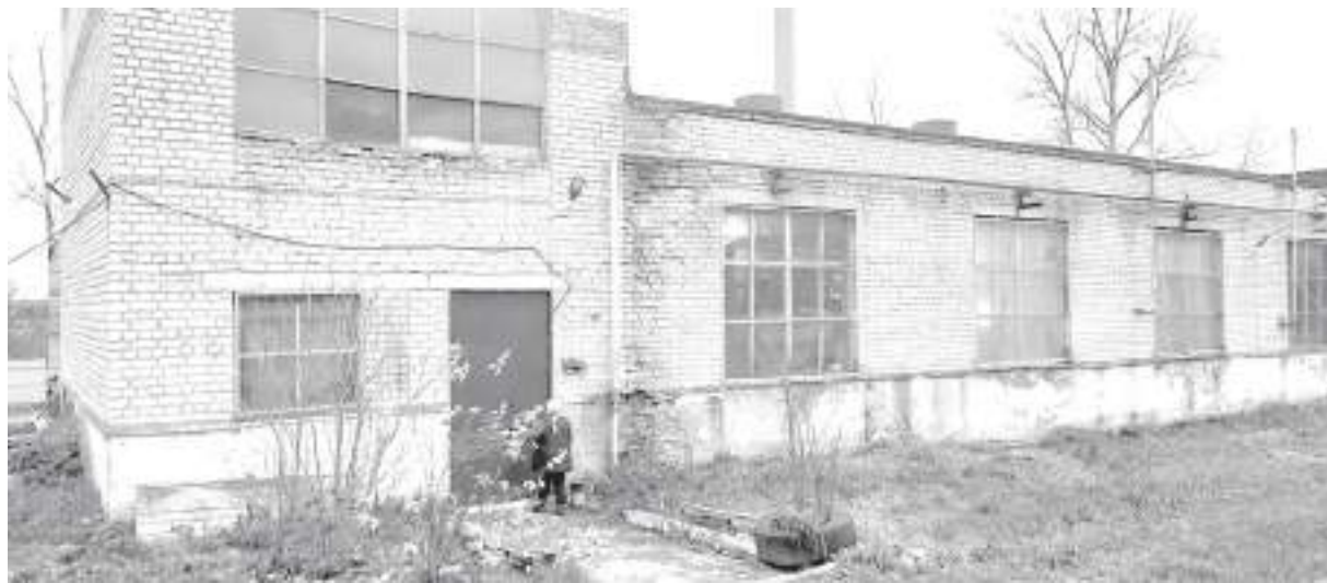
Сейчас в городе кипит работа по обеспечению резерва мощностей для устойчивой подачи тепла в холода
