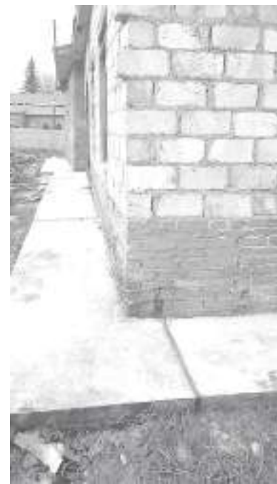
Эксперты провели контроль состояния зданий котельных, трубопроводов и котлов. На одной из них в порядок привели отмошкуну
