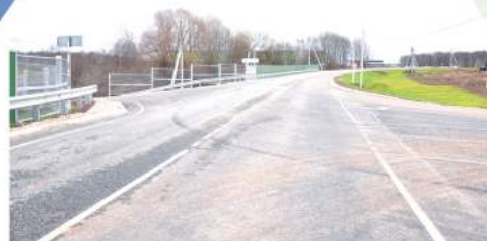
Дорожная разметка выполнена высокопрочным термопластиком
