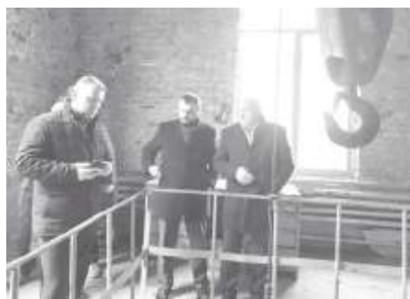
Николай КАЛИНИЧЕВ и Юрий ПЕТРУШИН посетили КНС, находящуюся в процессе ремонта
