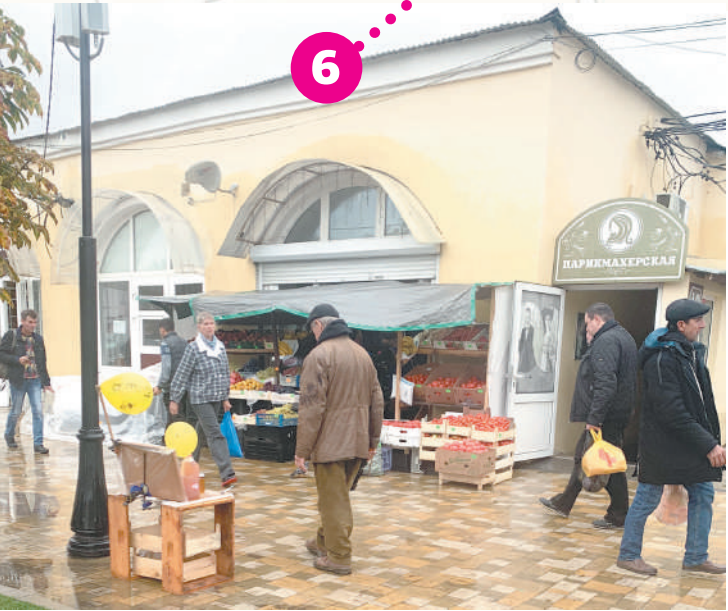
Изуродовать умудрились и лицевые фасады. Вот так «привлекательно» выглядит торговый комплекс на Ленина, 40
