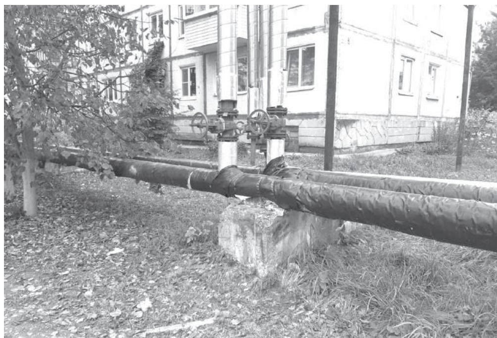
Накануне отопительного сезона трубы в Ермолине утеплили
