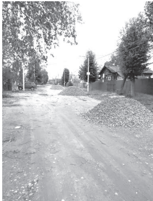
Улицу Ломоносова отсыпали щебнем после ремонтных работ по обустройству канализации
