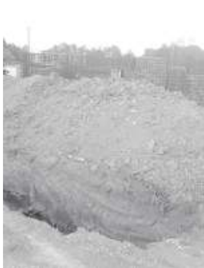
Подготовлены траншеи для труб. Они свяжут воедино всю систему
