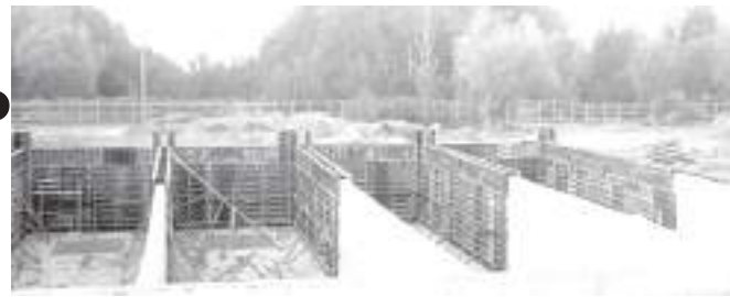
Для системы, где происходит фильтрация отходов, подготовили основание
