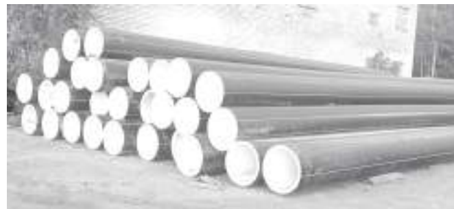
На стройплощадку завезли трубы
