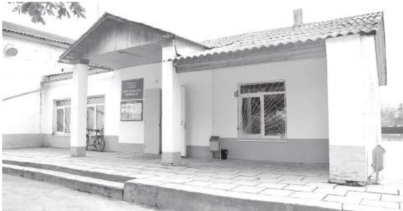
Реконструкция Дома культуры предусматривает не только ремонтные работы, но и пристройку дополнительных площадей
