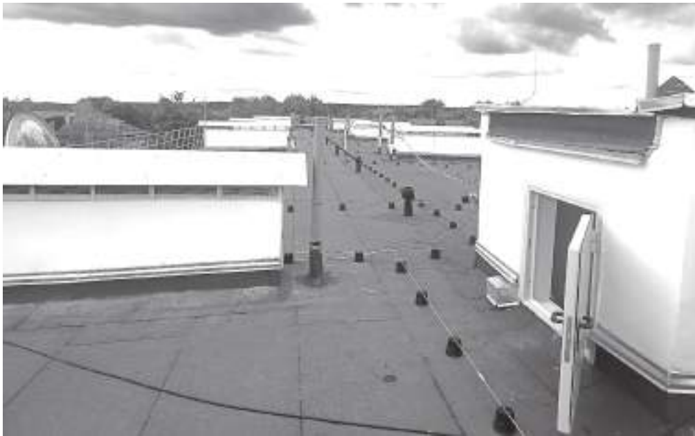
На площади Ленина, 7 выполнили большое количество работ по замене крыши
