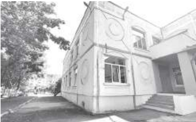
«Берёзке» очень нужен ремонт фасада и окружной дороги
