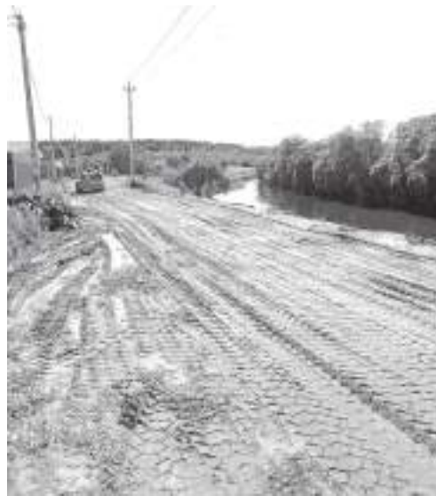
Грейдирование дорог входит в обязанности подрядчика
