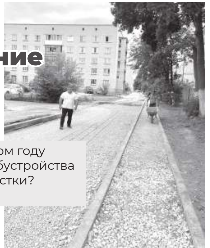
Работы по ремонту дворов контролирует мэр Евгений ГУРОВ
