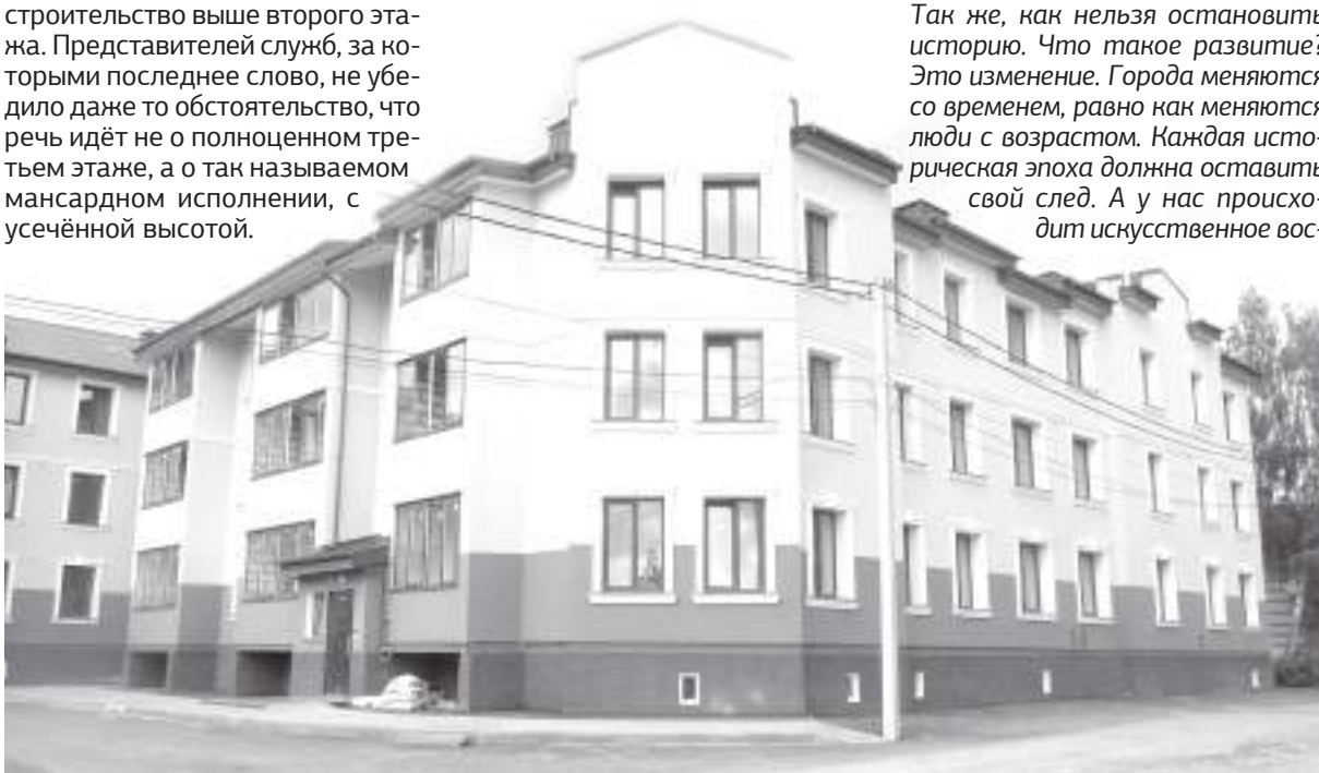
Новый дом пока пустует
