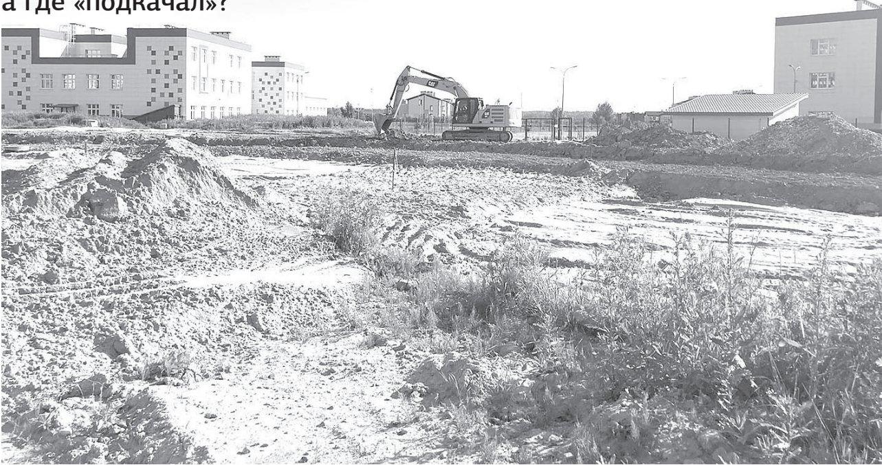
В Балабанове вовсю кипит работа по строительству новой дороги и тротуара
