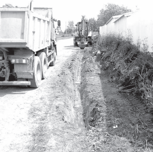
В Совхозе «Боровский» на улице Дачной перед укладкой асфальта провели подготовительные работы по очистке дренажа
