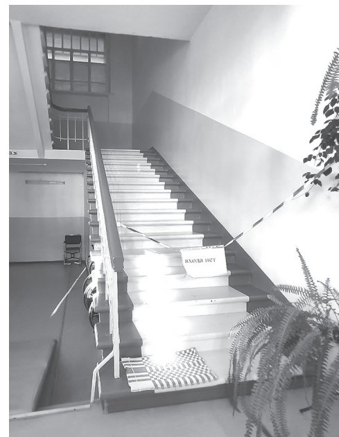
Второй этаж в Сестринском уходе нуждается в ремонте
