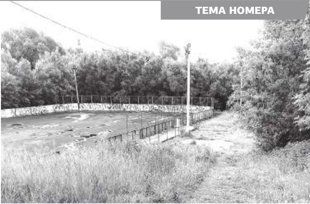
Спуск к хоккейной коробке оборудуют лестничным маршем
