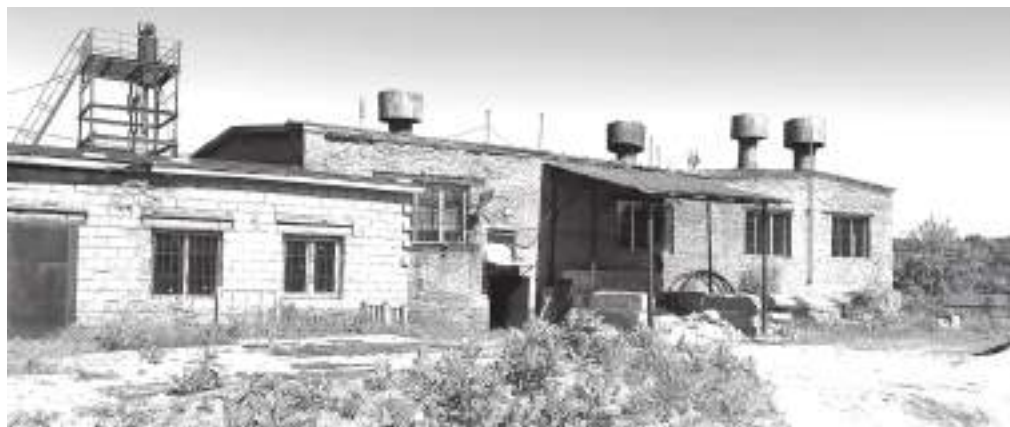
Котельные построили еще в 60-х годах
