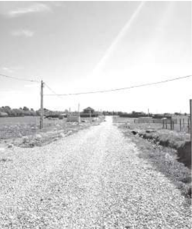
Часть технологических проездов в Красном отсыпали щебнем
