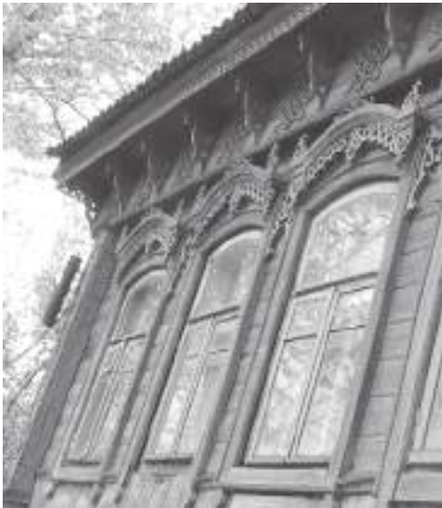
Сохранившиеся архитектурные детали
