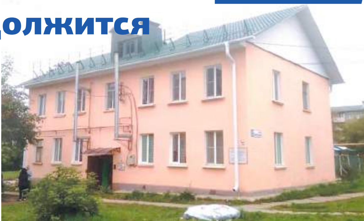
Дом № 21 на улице Коммунальной после ремонта кровли. Следующие на очереди – внутридомовые системы
