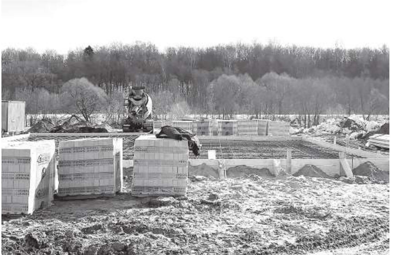
Собственник земельного участка возводит опалубку
