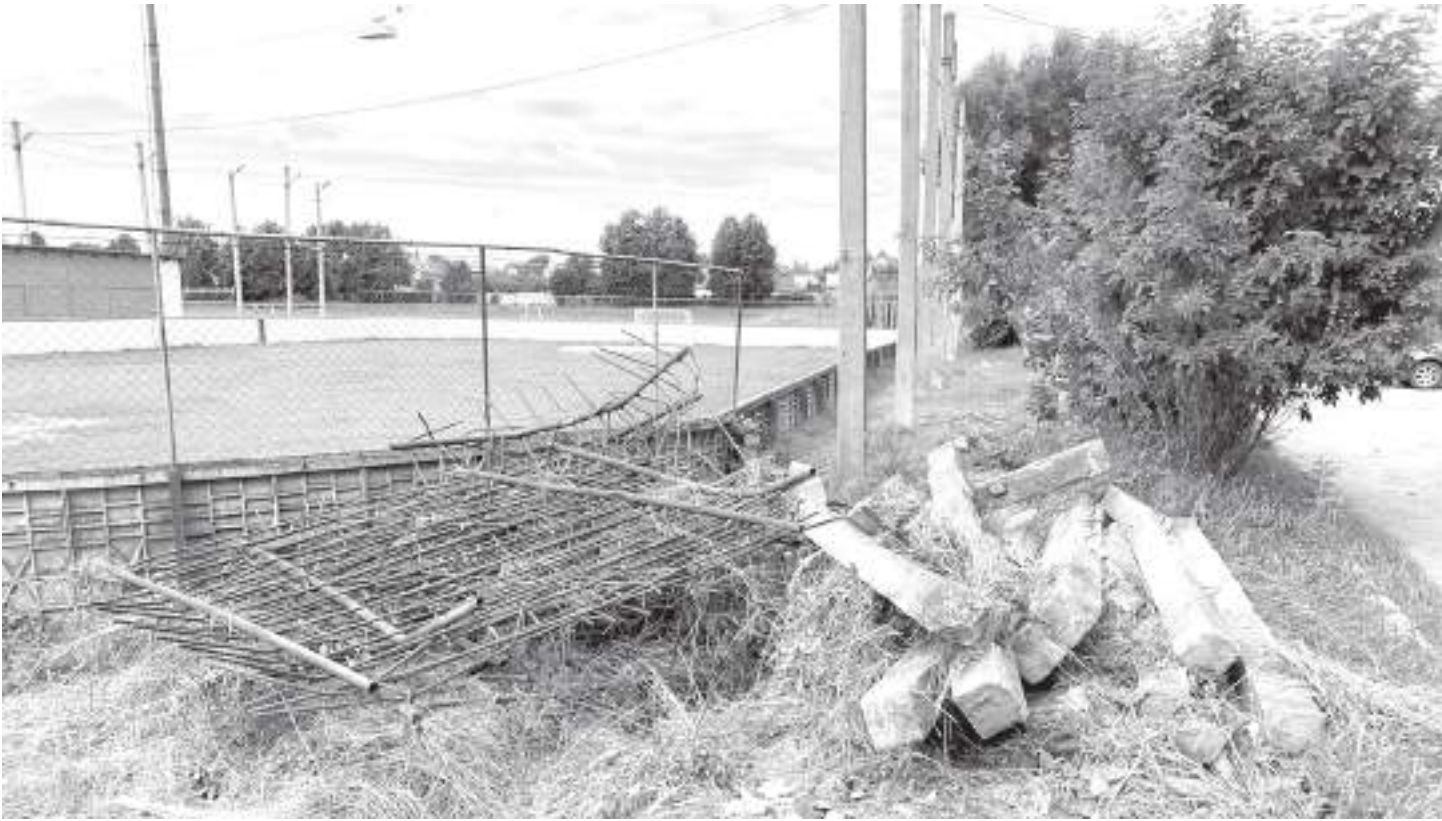
Металлоконструкции, оставшиеся с советских времен, давно требовали обновления
