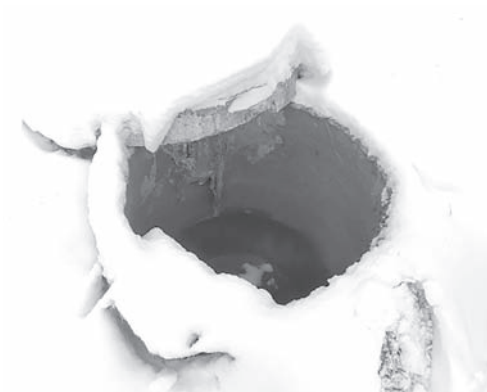
Открытые люки рядом с КНС, вероятно, олицетворяют «ответственность», с которой «Водоканал» подходит к делу
