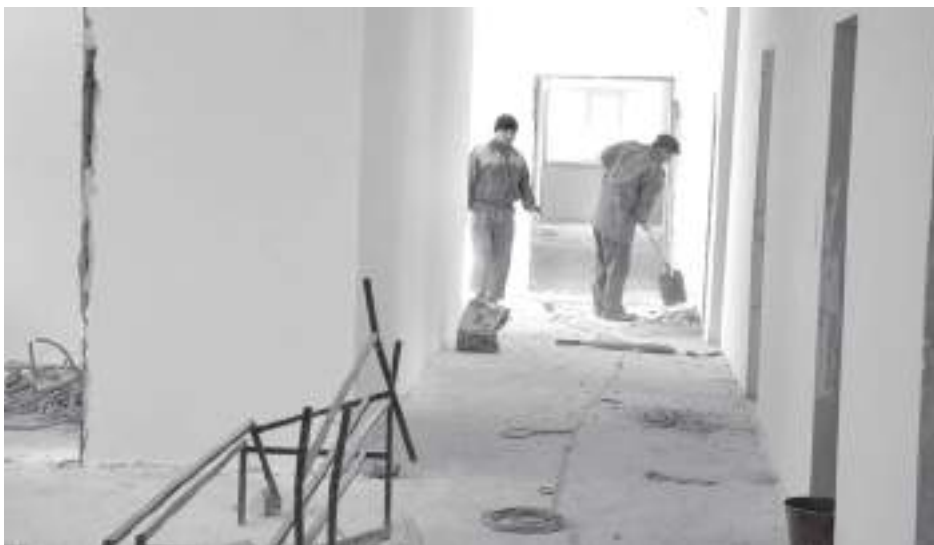
В здании поликлиники полным ходом идёт капитальный ремонт
