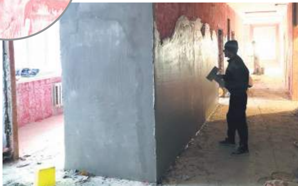
Рабочие штукатурят коридор и кабинеты второго этажа
