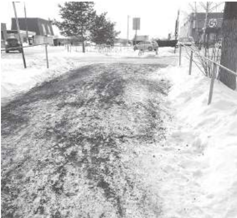
В Русинове отремонтировали ориентиры для незрячих людей
