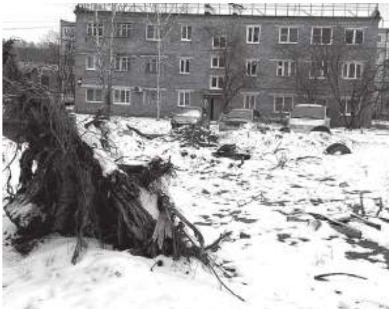
Заканчивать благоустройство предстоит новому подрядчику, который победит в электронном аукционе
